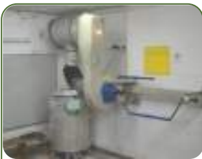
Іл. 39.5. Фільтровентиляційний агрегат
