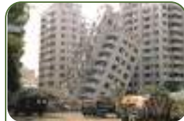
Іл. 33.15. Наслідки землетрусу
