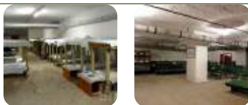
Іл. 39.3. Сховище: приміщення для укриття людей (варіанти облаштування)
