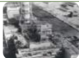
Іл. 36.10. Аварія на Чорнобильській АЕС
