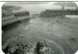
Іл. 33.8. Зруйнована вибухом гребля Дніпрогесу в 1941 р.
