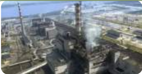
Іл. 34.2 Аварія на Чорнобильській АЕС
